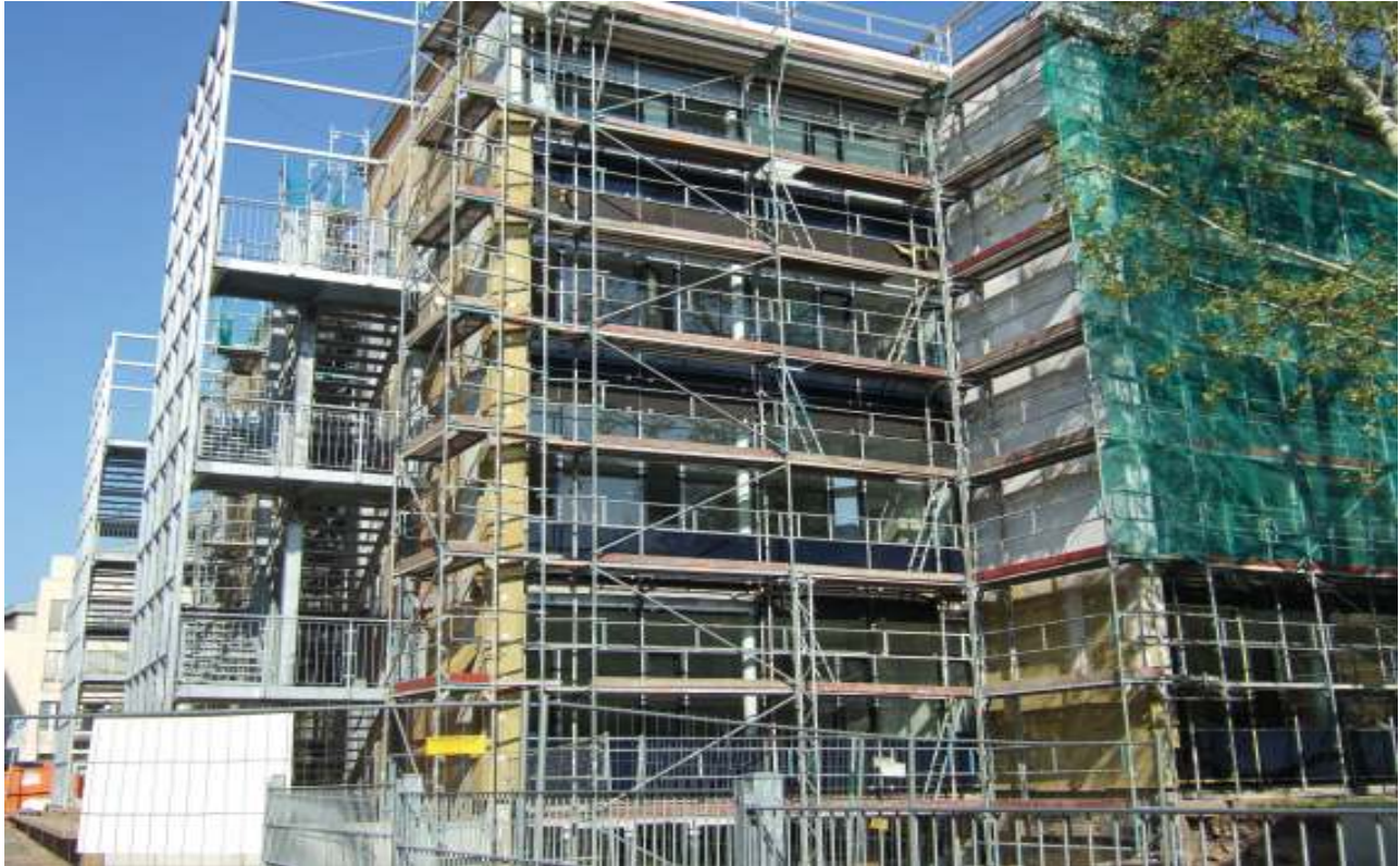
Fortführung Dämmarbeiten am Bestand / Fortführung der Glasfassaden – hier neuer Eingangsbereich
