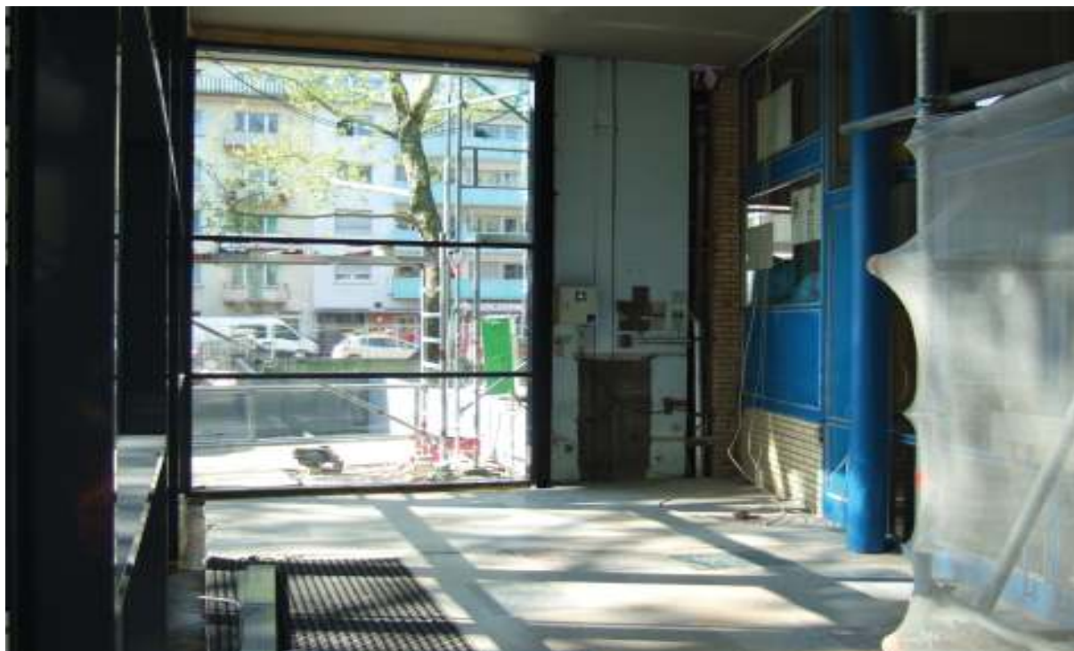
Zwischenstand Foyer ohne ehemaligem Hausmeisterraum (vor baulicher Sanierung des unteren Foyerbereichs)
