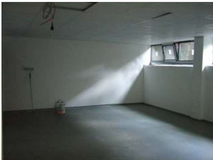
Lagerraum im KG
