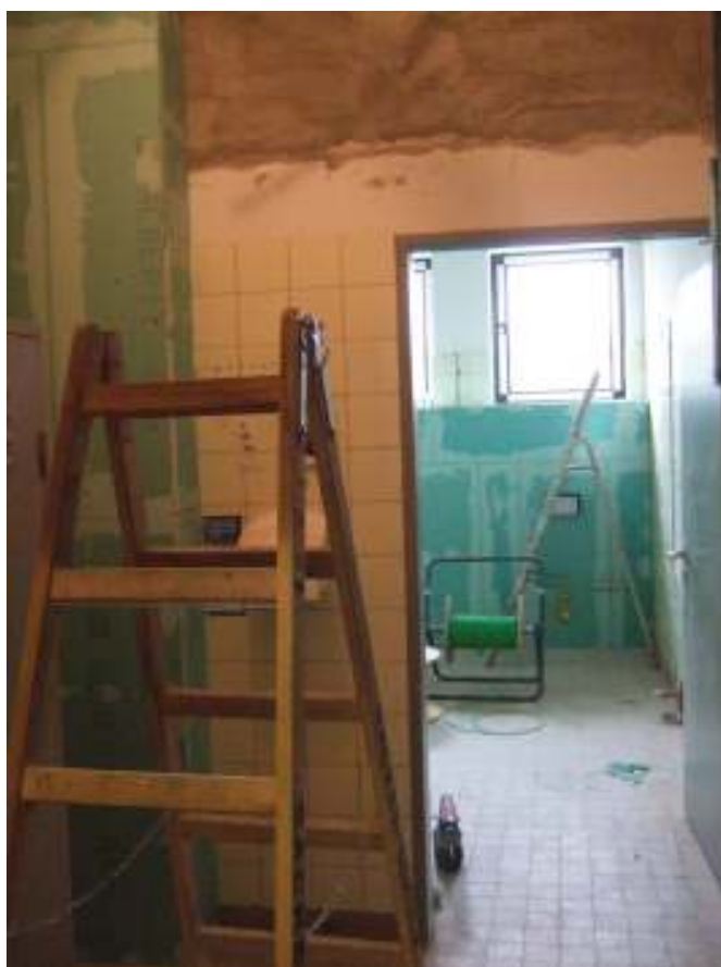
Sanierung WC-Anlagen Westflügel
