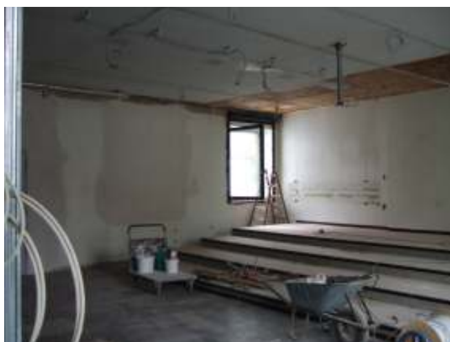
Erste Arbeiten in 1.OG Biologie
