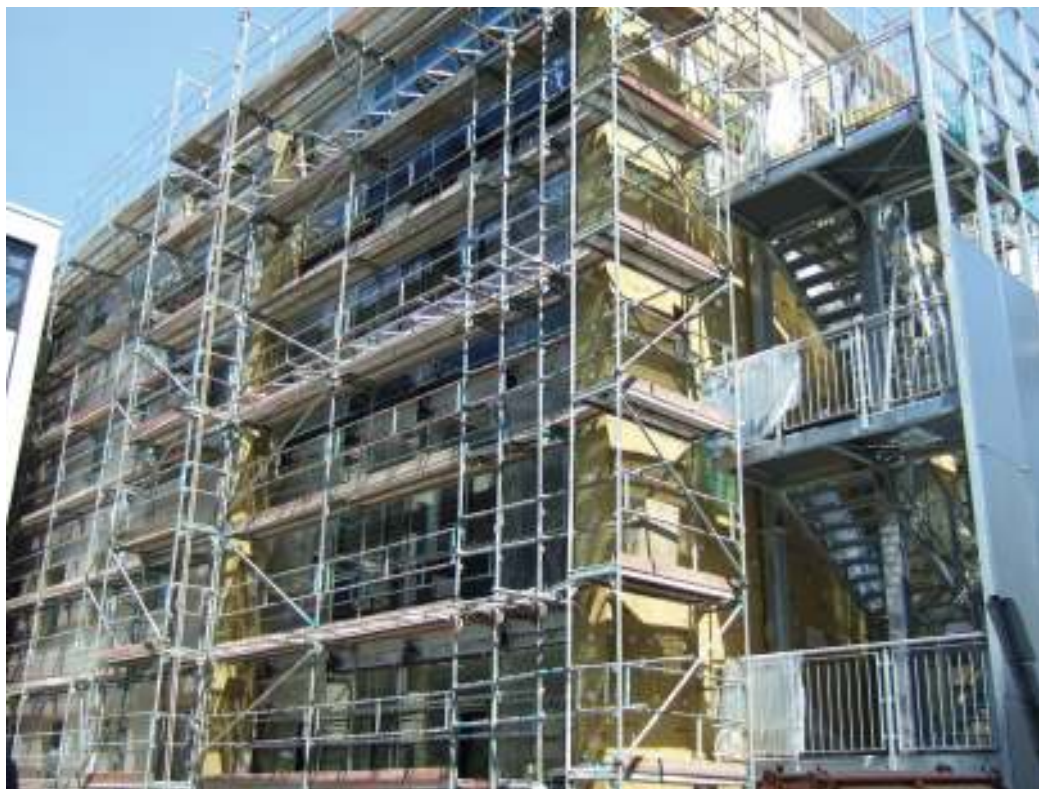
Energetische Sanierung Bestandsfassade/Verkleidung der neuen Nottreppenhäuser
