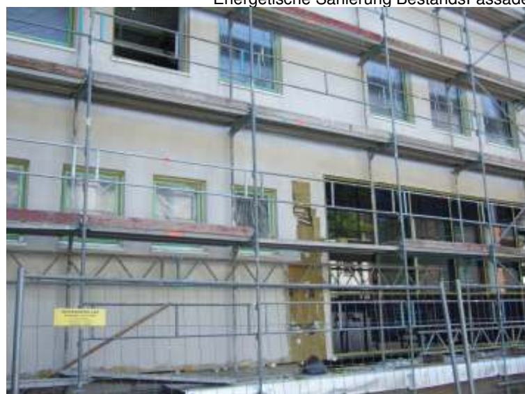
Energetische Sanierung BestandsFassade
