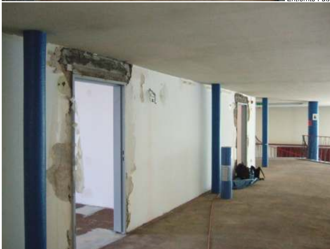
Entfernte Fußböden Aula/Neue Türen
