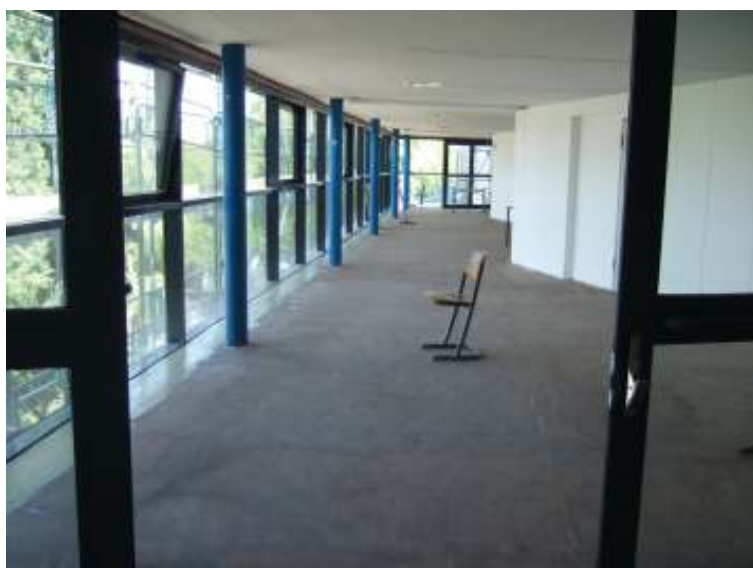
Entfernte Fußböden Stelzenbau
