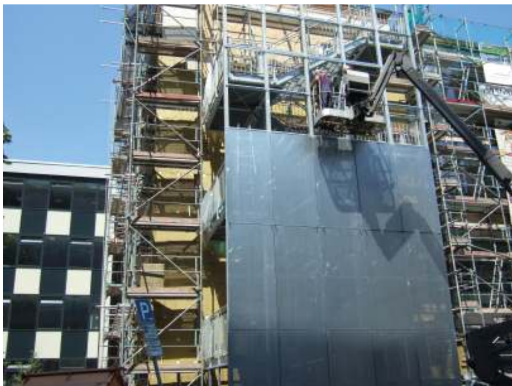
Energetische Sanierung Bestandsfassade/Verkleidung der neuen Nottreppenhäuser
