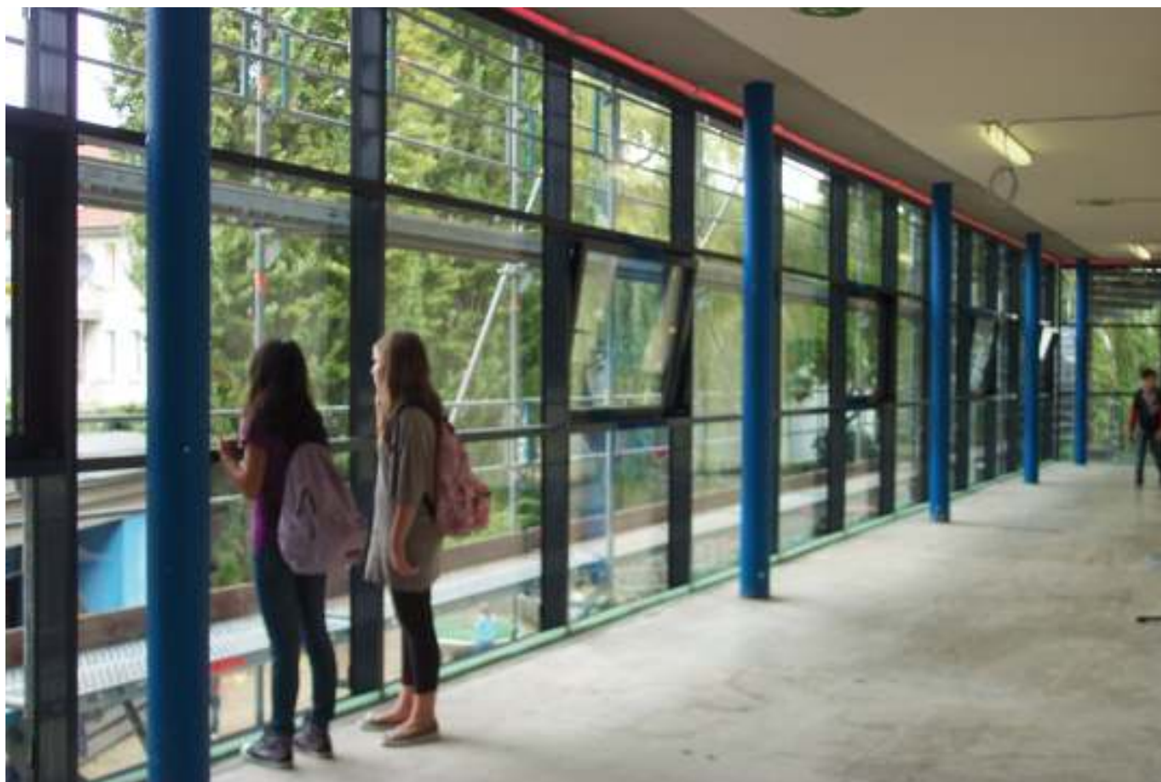
Sanierte Flurfassade Bestand Stelzenbau
