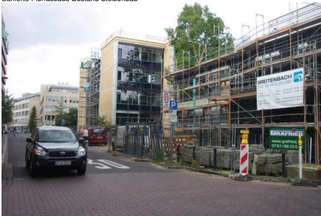
Sanierte Fassade Klassen Schlosstraße
