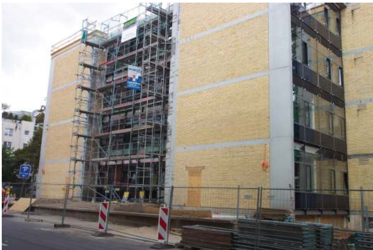
Neuer Anbau Mediothek Fassade
