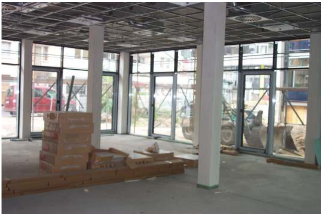
Neubau Cafeteria - Gastbereich
