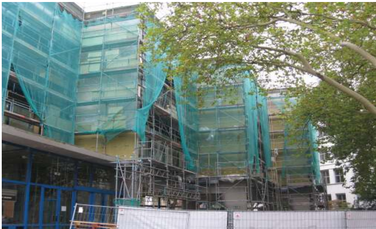
Wärmedämmung Südseiten Klassenzimmer
